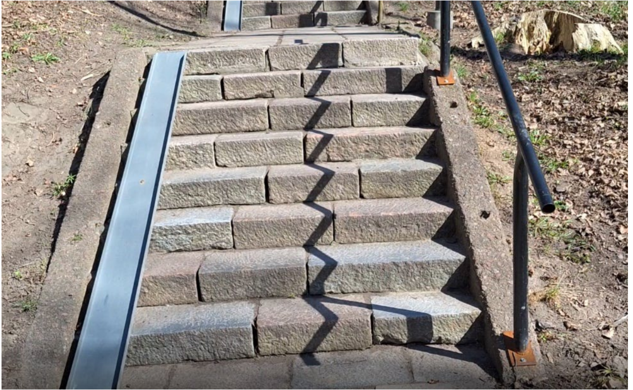
5 pav. Vytauto parko I laiptų autentiškų maršų esama būklė
