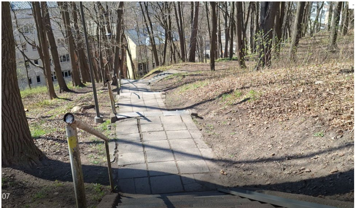
4 pav. Vytauto parko I laiptų maršų ir aikštelių esama būklė
